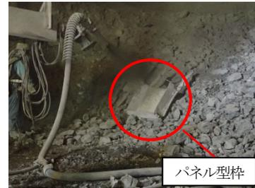
写真 6 パネル型枠への吹付け状況
