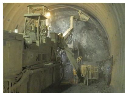
写真2 吹付けコンクリート施工状況
