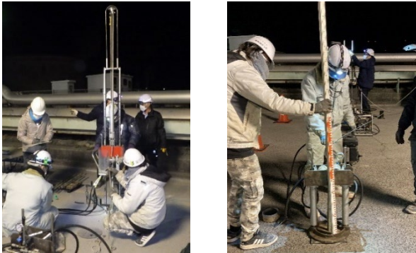
貫入時：小型動的コーン 引抜き時：電気検層
