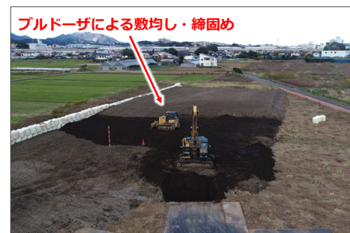
写真 2 盛土の施工状況
