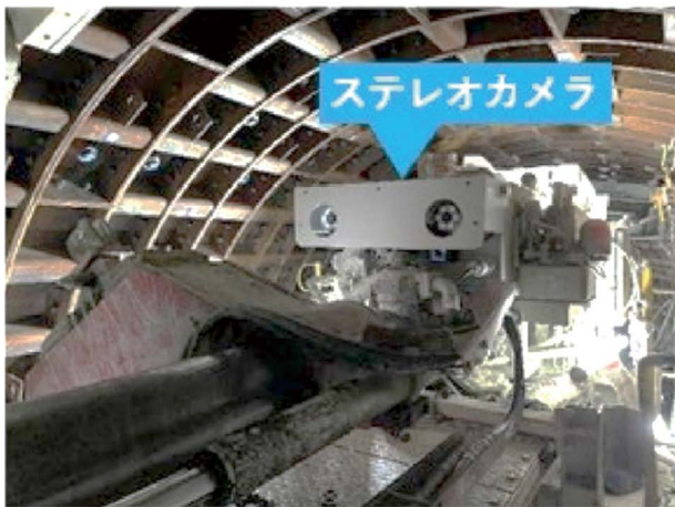
写真3 ステレオカメラ自動測量状況
