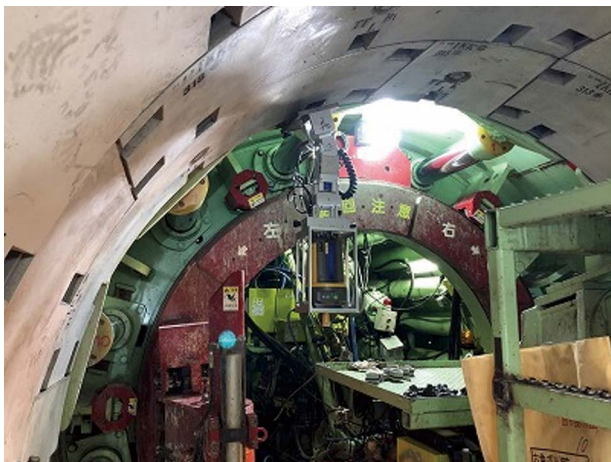
写真2 自動測量状況
