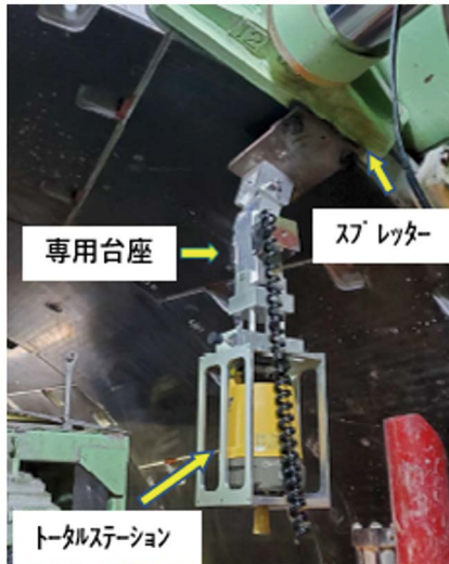
写真1 坑内自動測量システム
