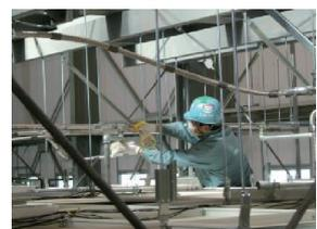
図-11 SP配管空気漏れチェック
