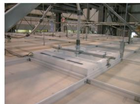
写真-4 天井上面 SPヘッド固定状況
