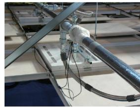
写真-6 加速度計設置状況(フレキ接続部)
