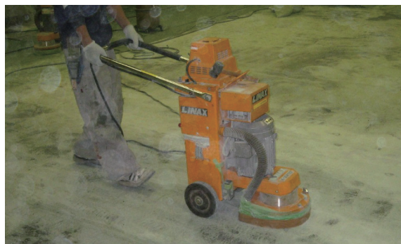
写真-1 研磨機による既存塗膜の除去
