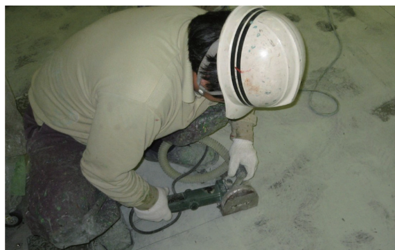
写真-2 溝切りの状況
