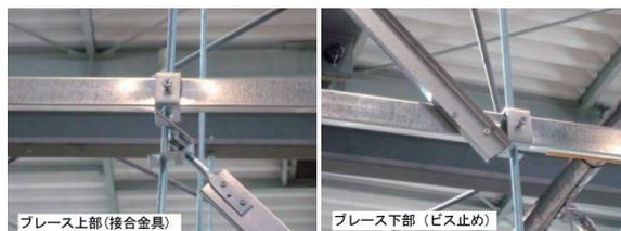
写真-2 鋼製下地接合部（斜め振れ止め）
