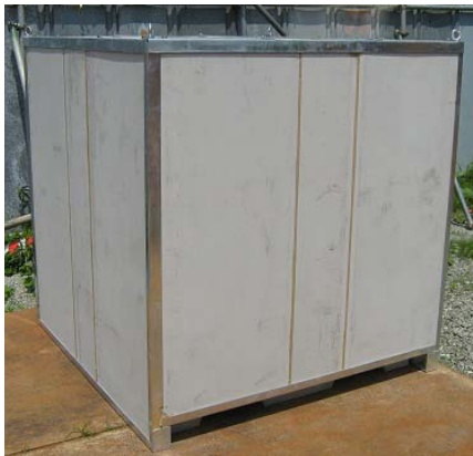
写真-3 遮蔽板を増強した状況
