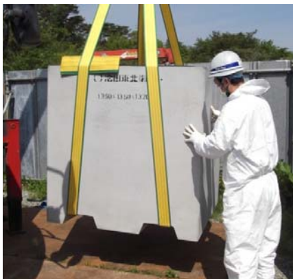
写真-4 スリングベルトによる吊り上げ状況
