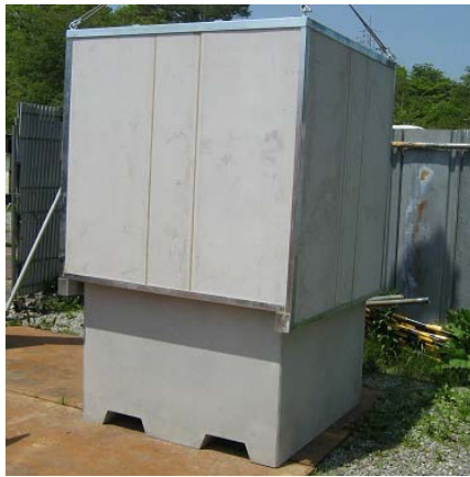
写真-2 遮蔽板で覆う作業状況
