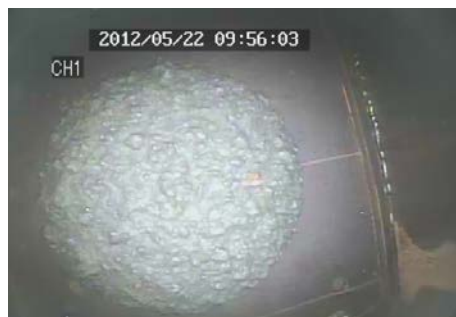
写真-2 柱内部の充填状況 (圧入工法)
