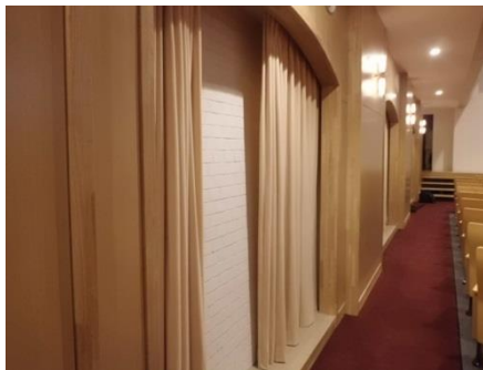
写真-2 アーチ型壁 壁上向き角度付、吸音カーテン開閉による残響可変
