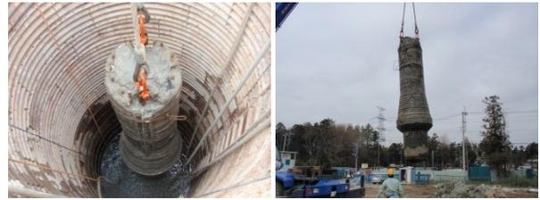
写真-5 試験杭掘出し状況
