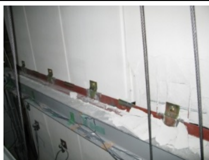
(b) 中間梁付近 ((a) の右側裏面)
