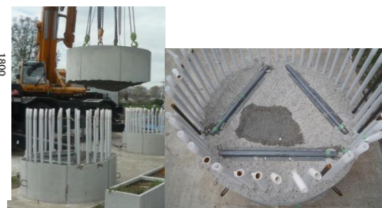
写真-7 余盛コンクリート撤去状況
