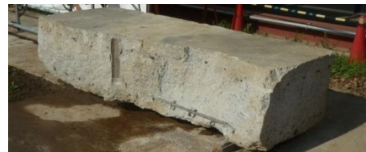
写真-5 ブロック化の状況(写真-4斜線部分)
