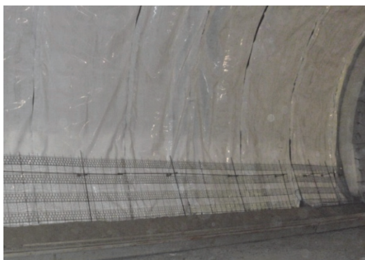
写真 - 11 覆工コンクリートへの適用例（無筋区間）
