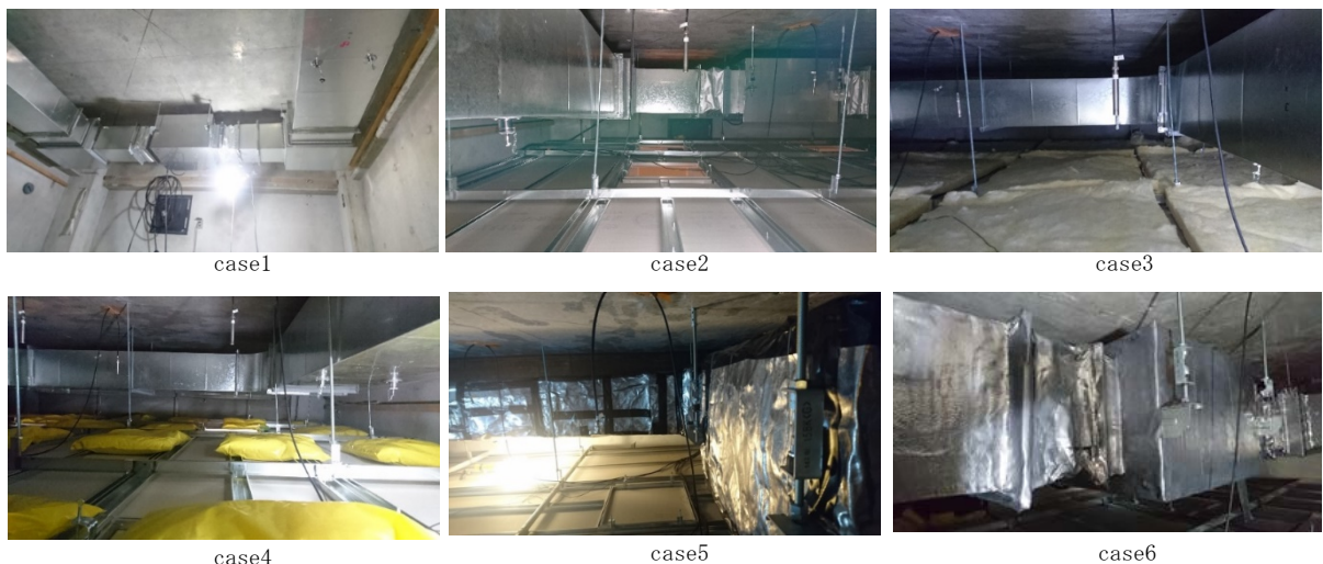
写真-2 ファン及びダクト、発生音低減対策の施工状況
