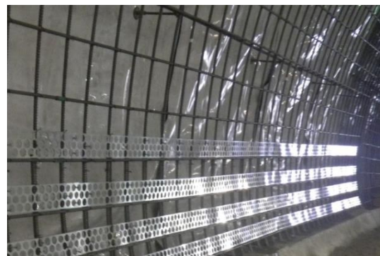
写真 - 11 覆工コンクリートへの適用例（有筋区間）
