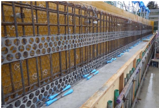
写真 - 9 ハイグリップ・メタルバンドのボックスカルバート高欄への施工例
