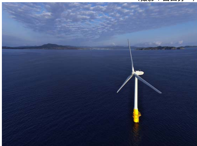
離島を臨む浮体式洋上風力発電施設「はえんかぜ」
