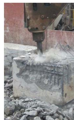
写真4 ジャイアントブレイカによる鉄筋コンクリートの解体状況(騒音・振動・粉塵が発生)
