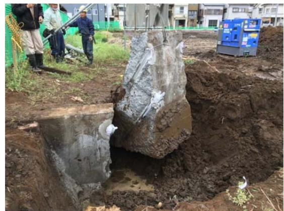
写真2 解体した擁壁の撤去状況
