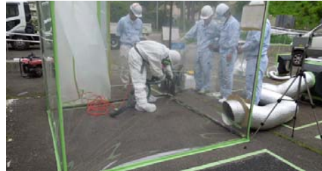
写真4 塗布乾燥後、隔離養生して除染
