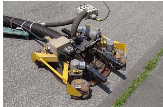
写真2 バキュームブラストロボットシステム
