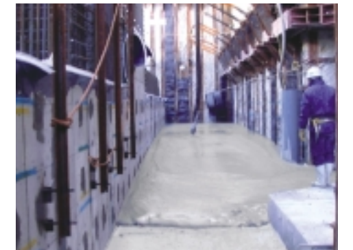
フライアッシュモルタル打設状況
