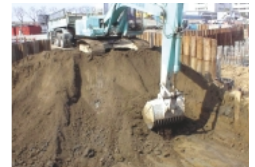
汚染土壌掘削処理状況
