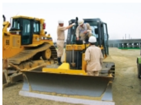
CO 2 削減手段の採用状況(土木作業所)
