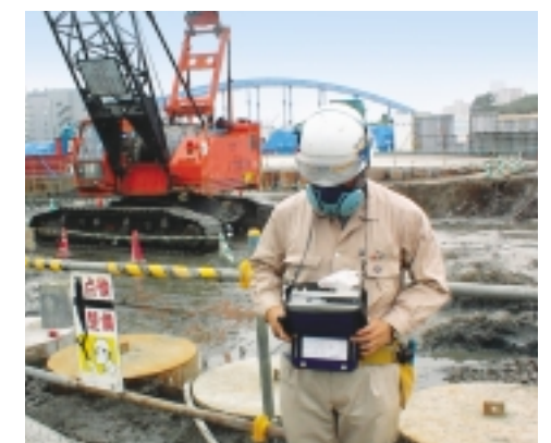
粉塵量測定状況
