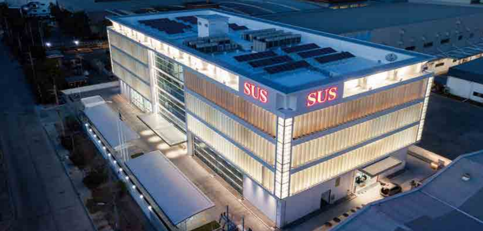
SUS BKK本社工場新築工事(タイ)
