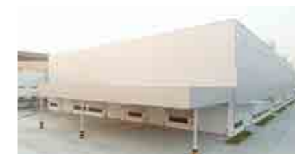
Ryobi Thai Factory Phase 2[タイ] 発注者：Ryobi Die Casting (Thailand) Co., Ltd. (タイ戸田建設(株)施工)
