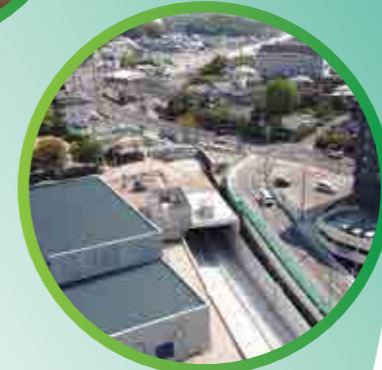
九州新幹線(西九州)、 諫早トンネル他
