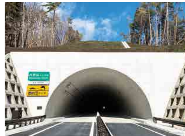
大峠山トンネル起点側坑口
