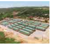
新設された中央市場全景
