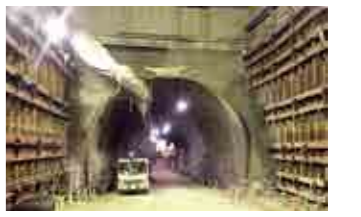
防音ハウス内のトンネル掘削状況
