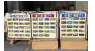
作業所の分別ヤード
