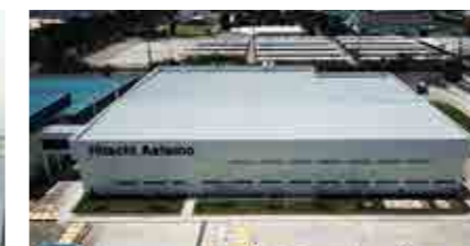
Hitach Astemo Factory-2 Extension Project[タイ] 発注者：Hitach Astemo Lamphun Ltd. (タイ戸田建設(株)施工)
