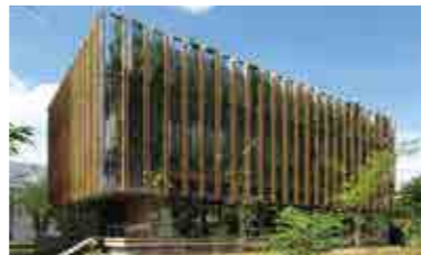
グリーンオフィス棟(2021年5月竣工)
