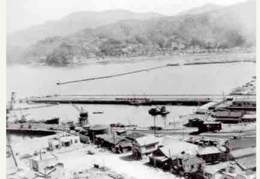
1939年 日本製鐵釜石港突堤
