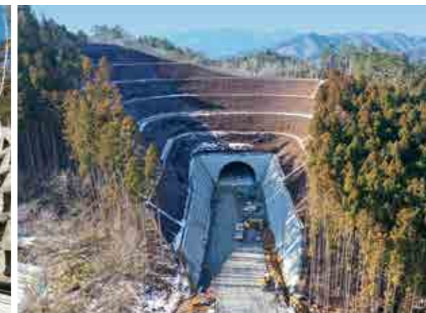
大峠山トンネル終点側道路改良
