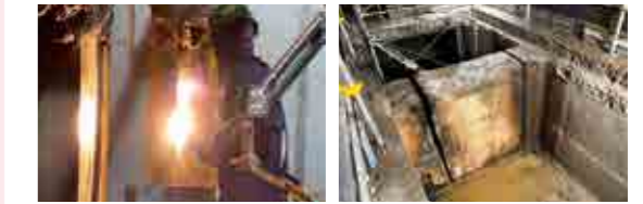
ガス切断状況(RC構造物)
