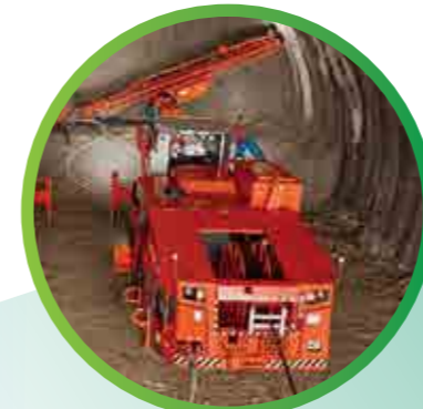
ロボルト (ロックボルト自動打設機)
