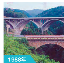
1988年 老ノ坂亀岡バイパス橋
