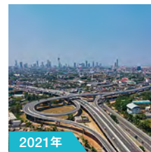
2021年 ケラニ河新橋建設工事
