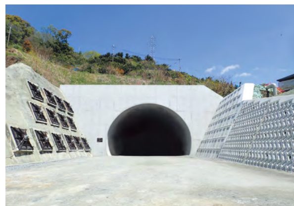
有田海南道路5号トンネル工事
