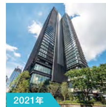
2021年 常盤橋タワー
