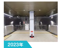
2023年 相鉄・東急直通線 綱島トンネル
