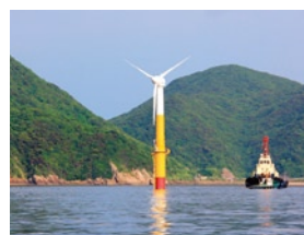
洋上設置が完了した小型試験機
