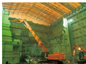
テント内で施設を解体する様子
