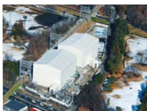
作業所を覆う大型ビームテント
