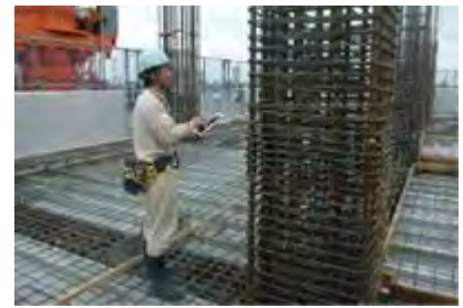
配筋検査状況
