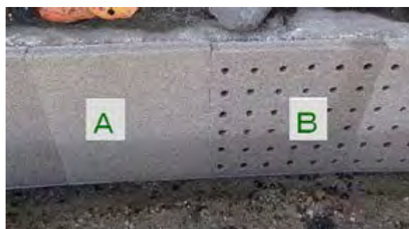
A: 製造コストを半減した改良パネル(右)、 B: 同上パネルに穴明け(左)
