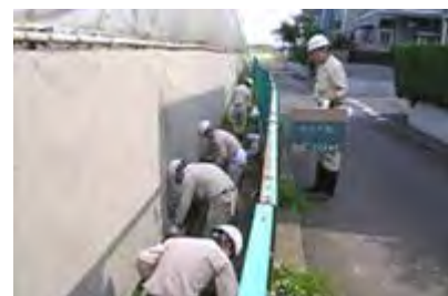
草刈り、水路清掃の様子
