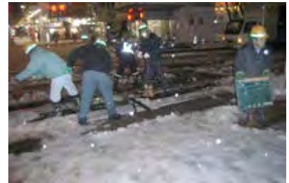
除雪作業の様子
