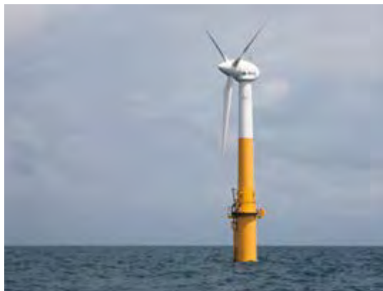
100kW風力発電設置の様子
