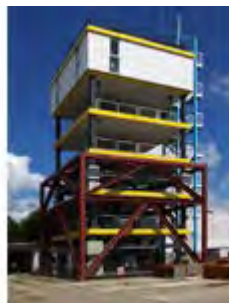
実大振動試験装置
