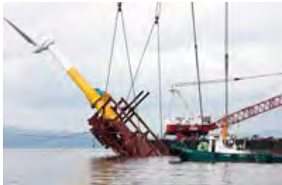
海上での施工風景
