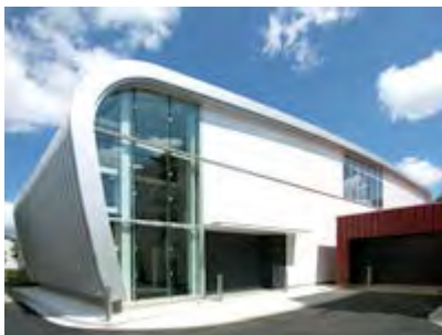
丸みのある屋根が特徴的な音響実験棟
