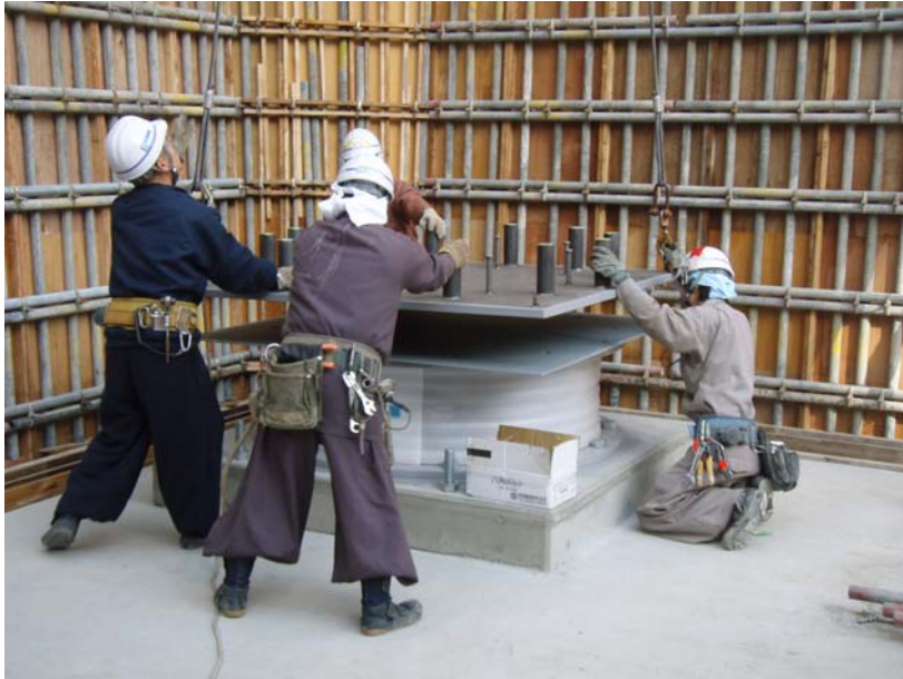
積層ゴム取付状況
