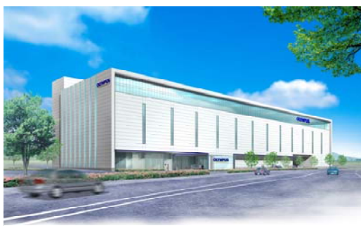
会津オリンパス : A 棟 (施工中) 工場、地上 5 階、軒高 29.56m
