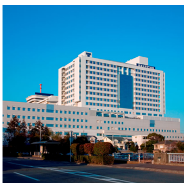
東海大学医学部付属病院 (2005 年 9 月竣工) 病院、地上 14 階地下 1 階、軒高 74.3m
