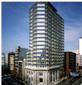
D' グラフォート横浜 (2004 年 3 月竣工) 集合住宅、地上 21 階、軒高 71.4m
