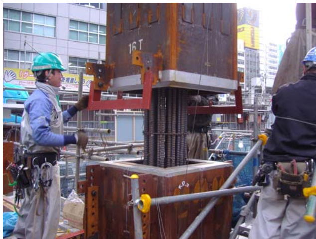
鉄筋挿入状況
