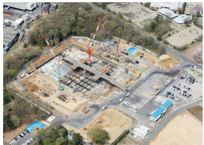
写真1 2012年4月現在施工状況写真
