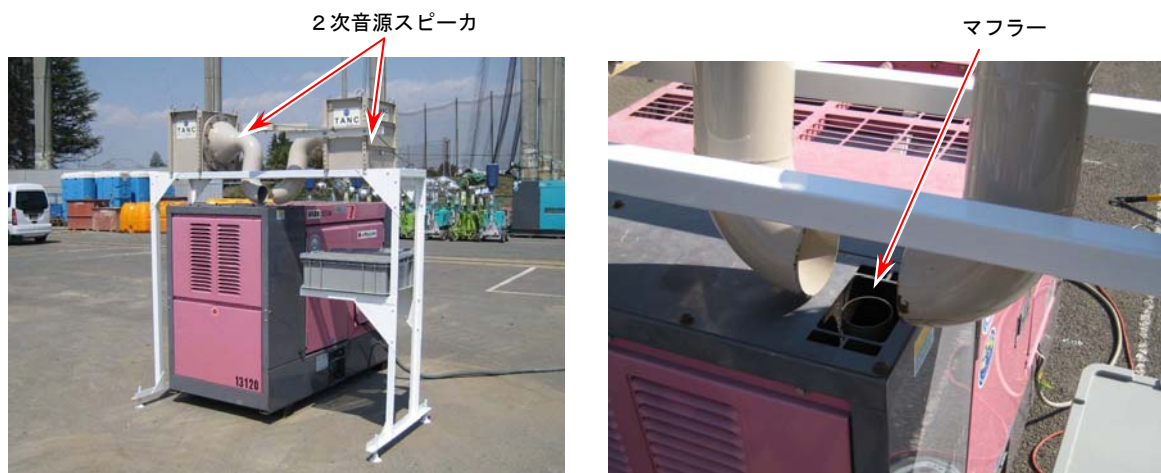
写真1 「発電機TANC（タンク）」の設置状況
