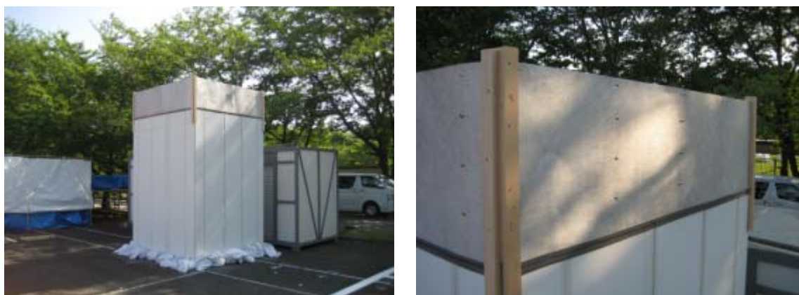
写真1 実大実験の状況（エッジ効果抑制材の設置状況）
