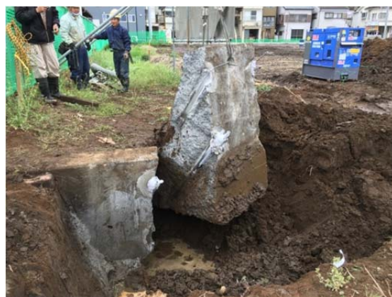
写真2 解体した擁壁の撤去状況
