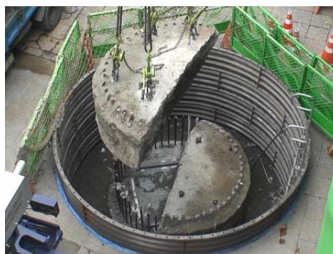
写真2 余盛コンクリート撤去状況
