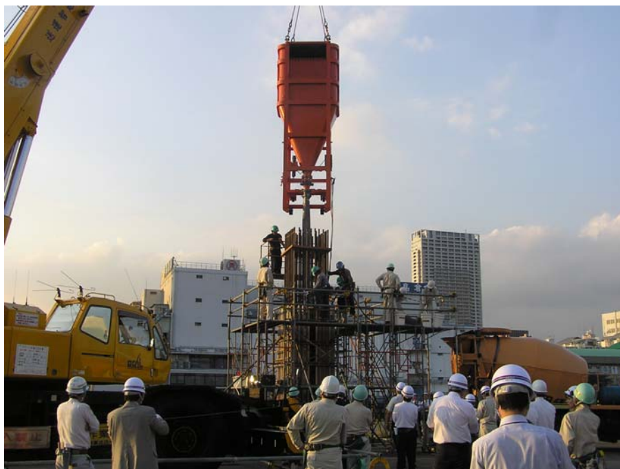
図5 Fc130N/mm 2 級の超高強度RC柱の施工実験
