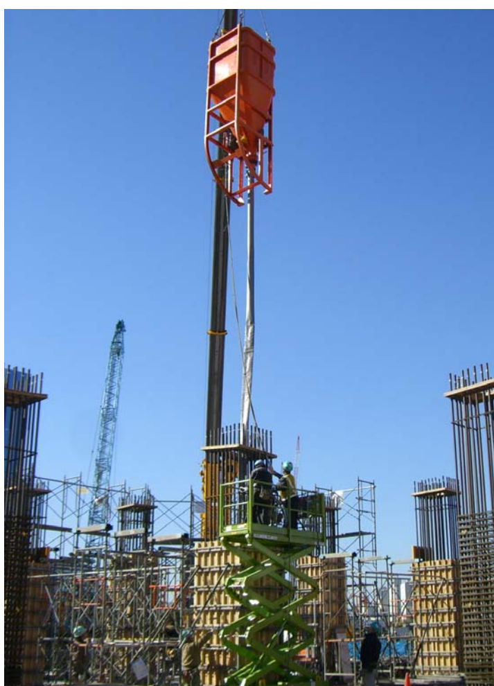
図6 Fc130N/mm 2 級の超高強度RC柱の施工
