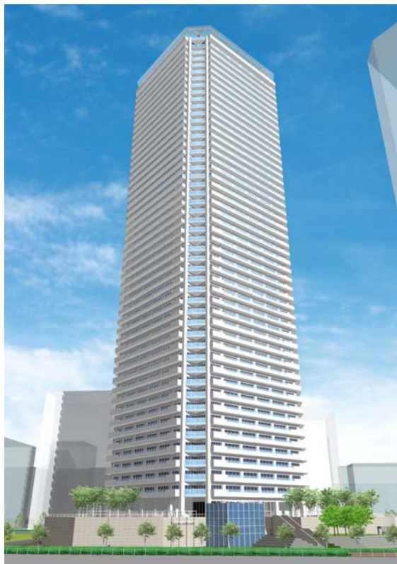
図4 超高強度RC柱を採用した49階建ての超高層住宅
