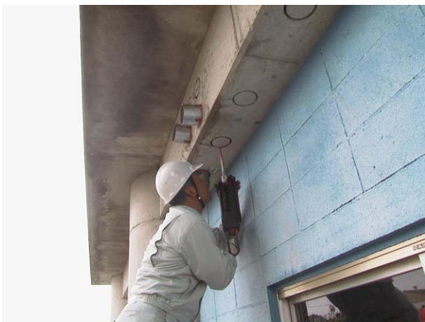
写真 - 8 . 接着材注入状況
