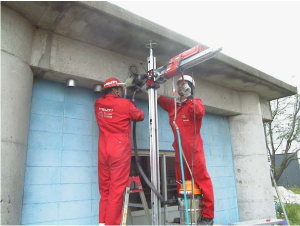
写真 - 6 . 上向き削孔状況
