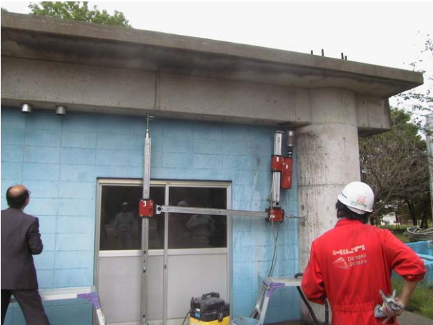
写真 - 7 . 横向き削孔状況
