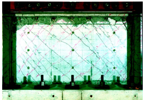
写真 - 4 . W K - 0 3 試験体破壊状況
