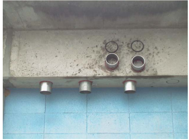
写真 - 9 . 鋼管コッター設置状況
