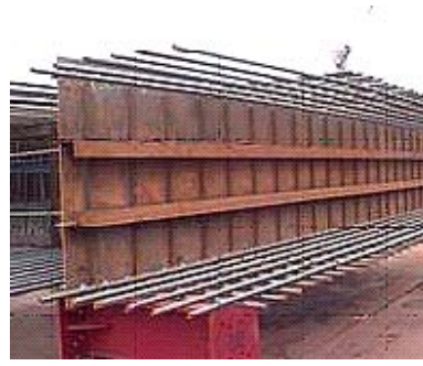
② 鉄筋カゴ組立・壁間継手
