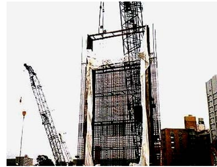
③ 鉄筋カゴ建込み
