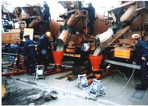
④ コンクリート打設
