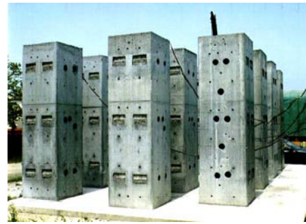
図 7 高強度コンクリートの施工実験
