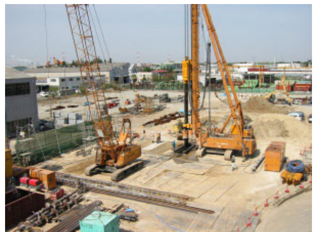
写真 - 1 施工性確認試験実施状況
