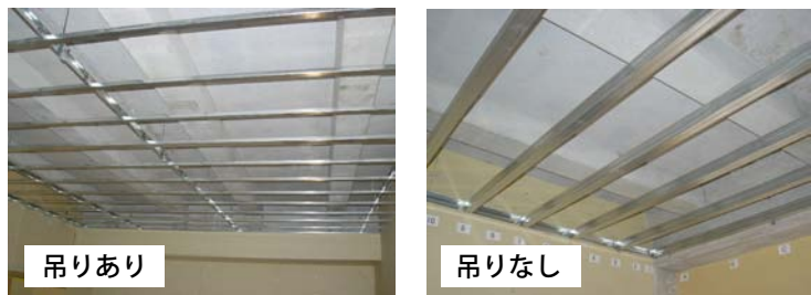
写真-1 天井下地
