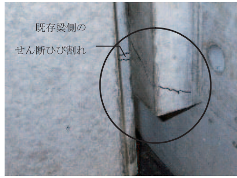
図-7 a-1試験体の破壊状況
