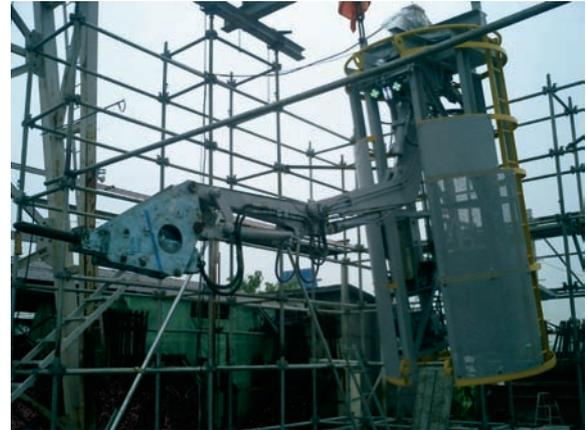
写真-3 除染・レンガ解体ロボット
