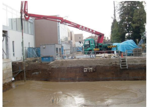
写真1 流動化処理工法施工状況
