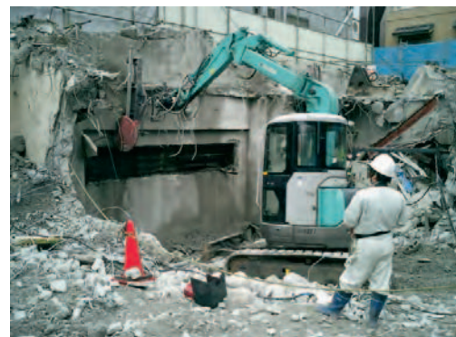
写真-2 施工状況（梁切断）
