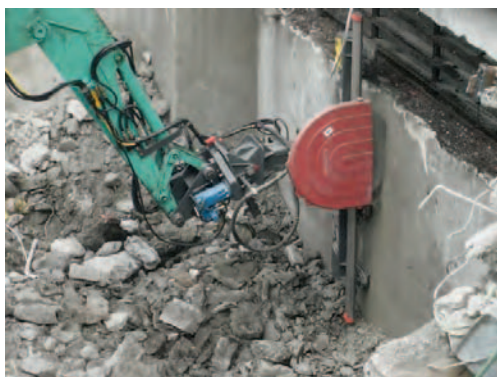
写真-4 縦切りの施工状況
