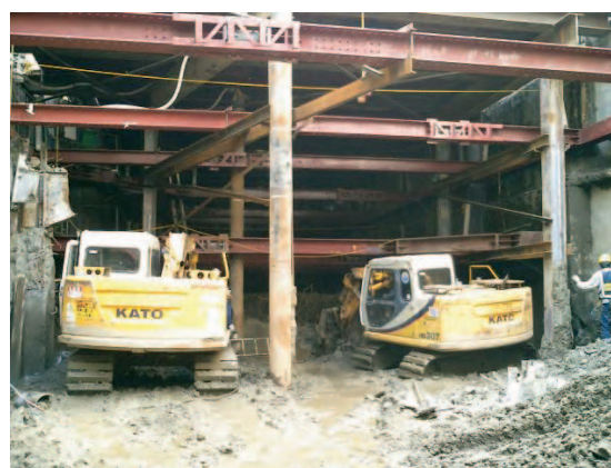
写真-1 地下既存躯体解体工事の状況
