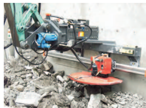
写真-3 横切りの施工状況
