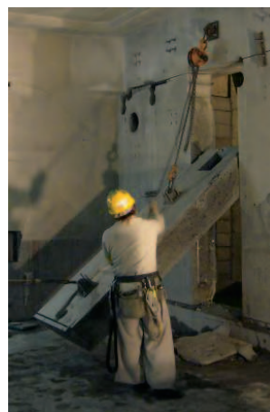
写真-6 切断部材撤去状況
