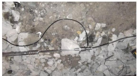
写真-4 挿入補助装置
